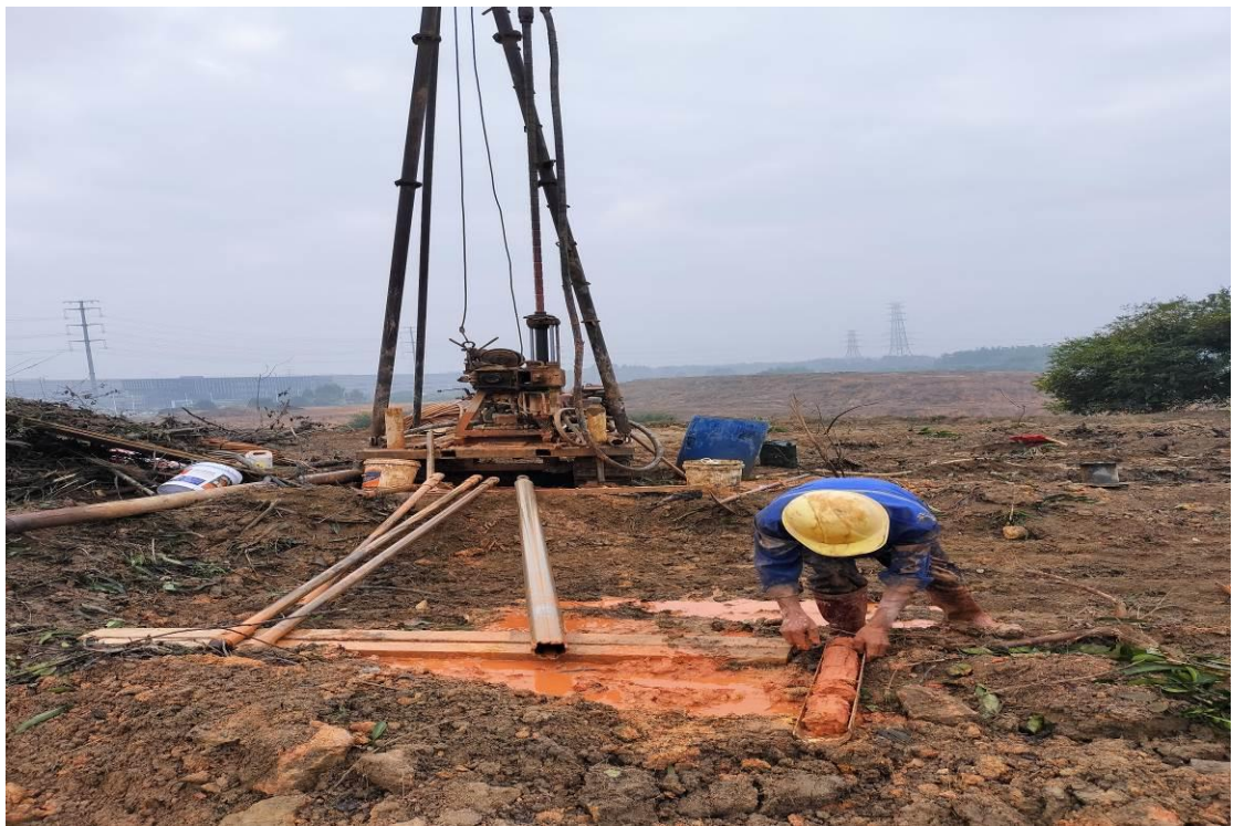
照片 2 ZK2 地块现状
