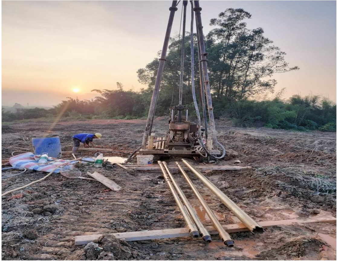
照片 1 ZK1 地块现状
