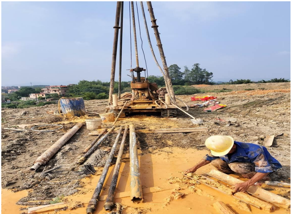
照片 4 ZK4 地块现状
