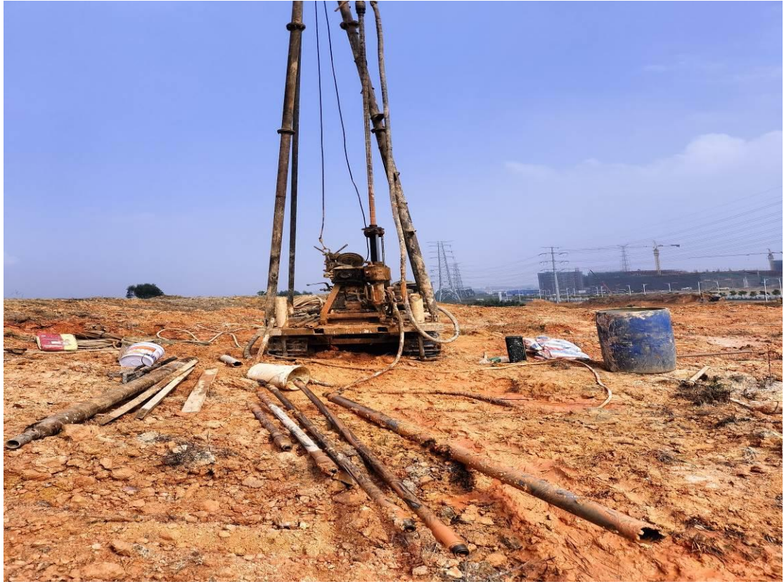
照片 3 ZK3 地块现状
