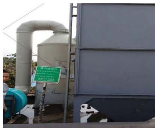
图34: 酸雾废气处理装置
