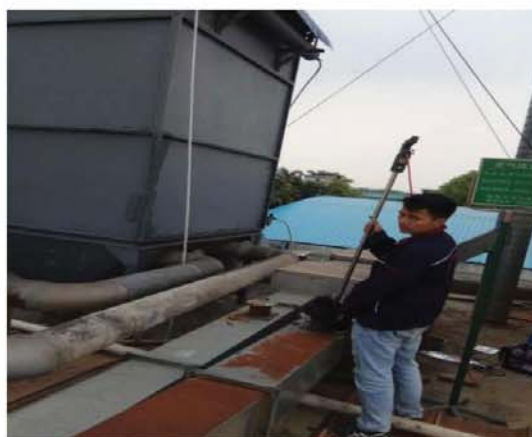
图8: FQ4-17052 热固化废气采样口1 (处理前1)
