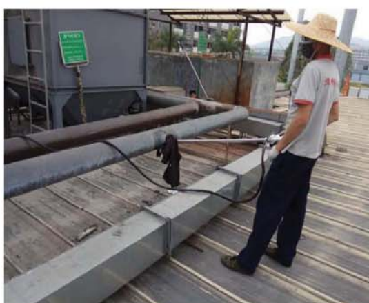
图11: FQ3-17052 炉窑废气采样口1 (处理前1)
