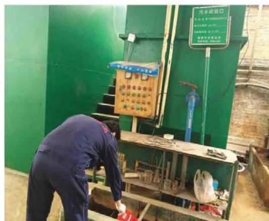
图20: WS-17052 废水排放口（处理后）
