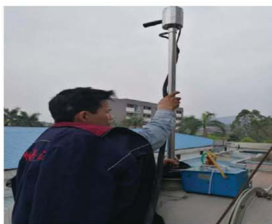
图14: FQ1-17502 酸洗废气采样口 (处理前)
