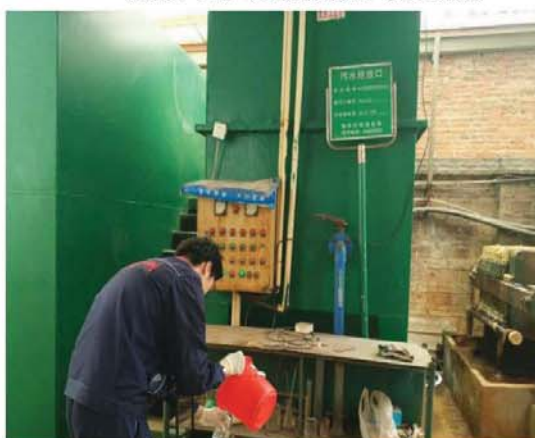
图21: WS-17052 废水排放口（处理后）
