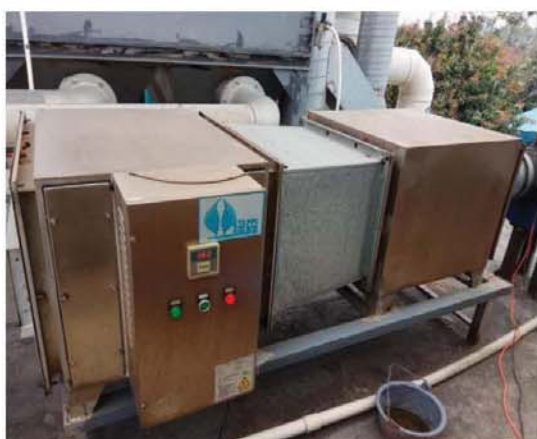
图33: 热固化废气处理装置
