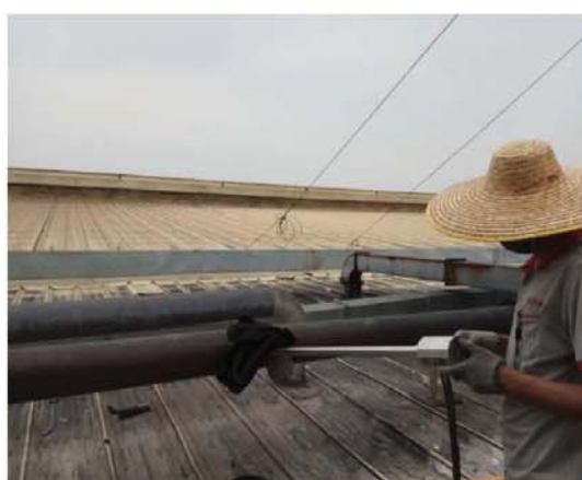
图12: FQ3-17052 炉窑废气采样口2 (处理前2)
