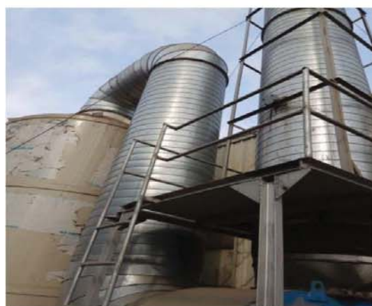
图35: 焊接废气处理装置
