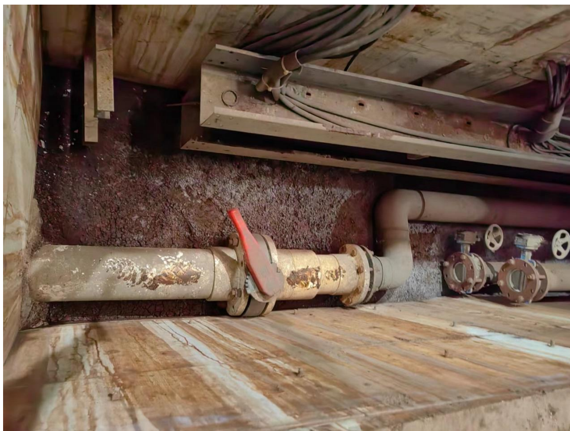
图 2.7-2 雨水管网与厂房 1 镀锡车间的基坑 2 阀门
