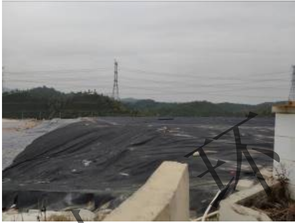
临时封场的第一填埋区
