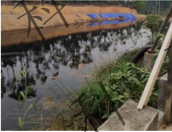
渗滤液调节池
